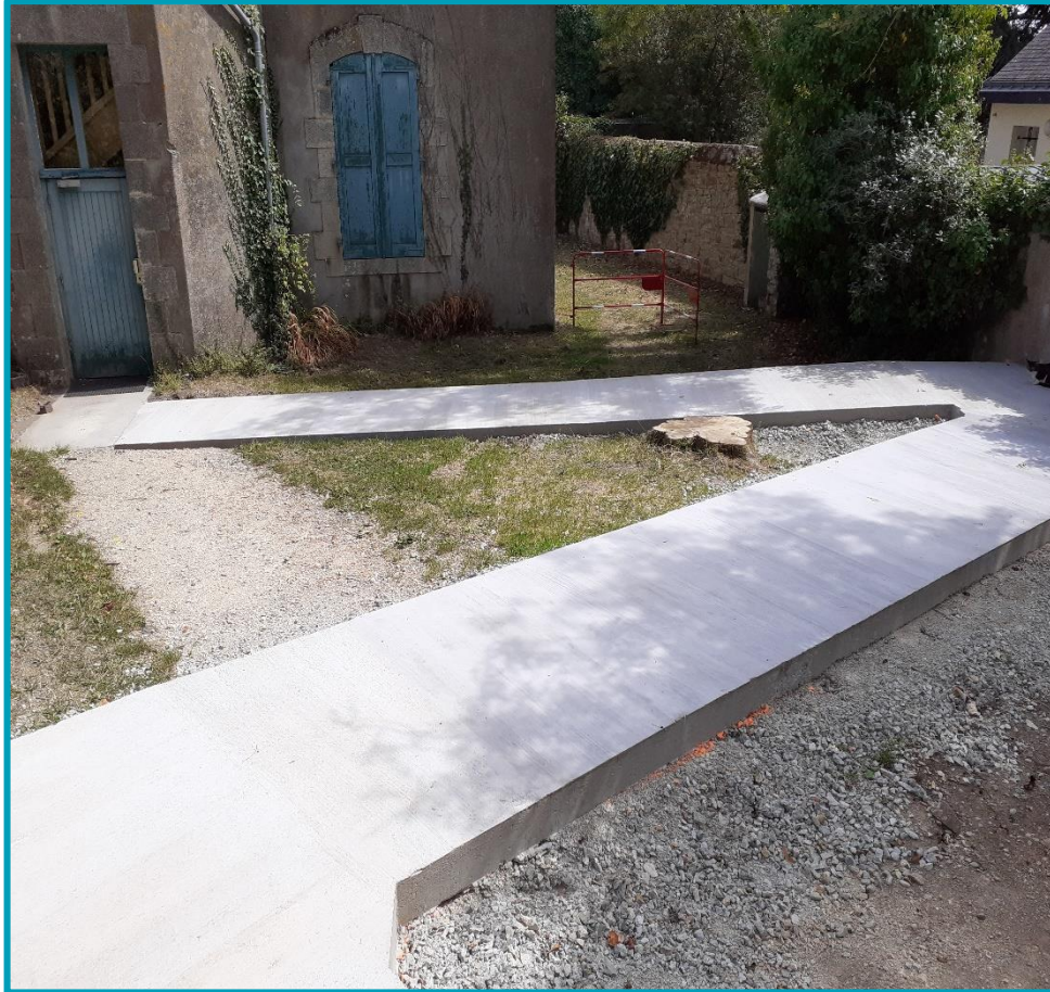
Rampe d'accès école Diwan
